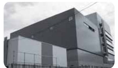
部室棟 左側と工事中の東館
